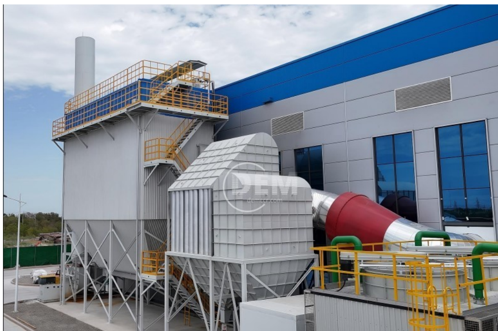
Slika br. 3.2.2-13: Filtersko postrojenje za 2 seta peći za topljenje + 2 seta peći za držanje u liniji za kontinuirano livenje i valjanje aluminijumskih šipki
